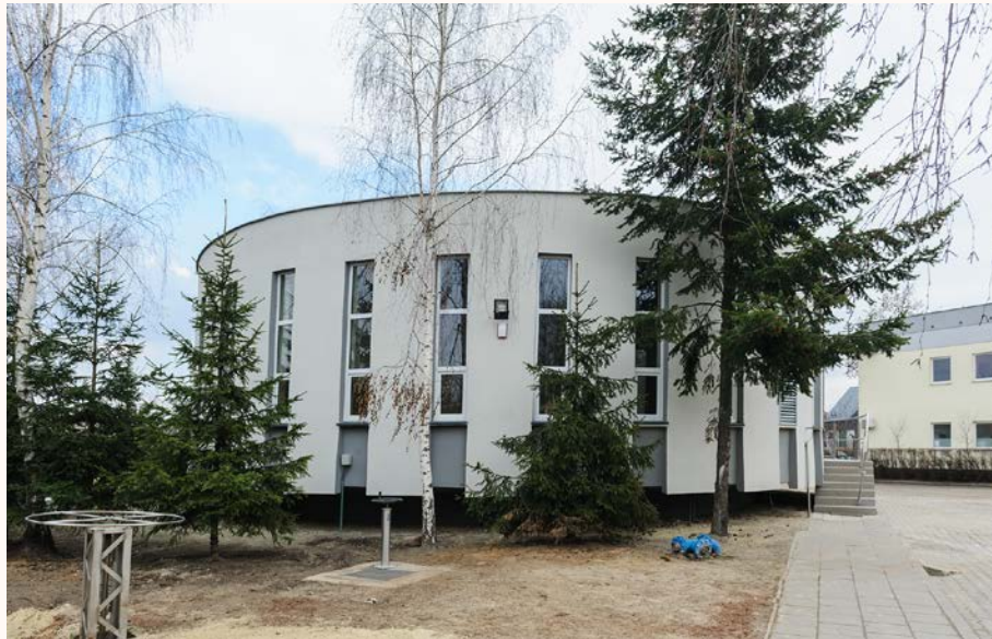
„Gruba Kaśka”, 2014 r. (po modernizacji)
