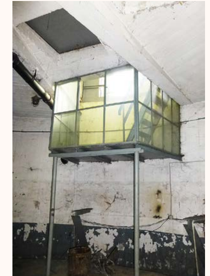
„Gruba Kaśka” – wewnątrz budynku podczas prac modernizacyjnych w 2013 r.
