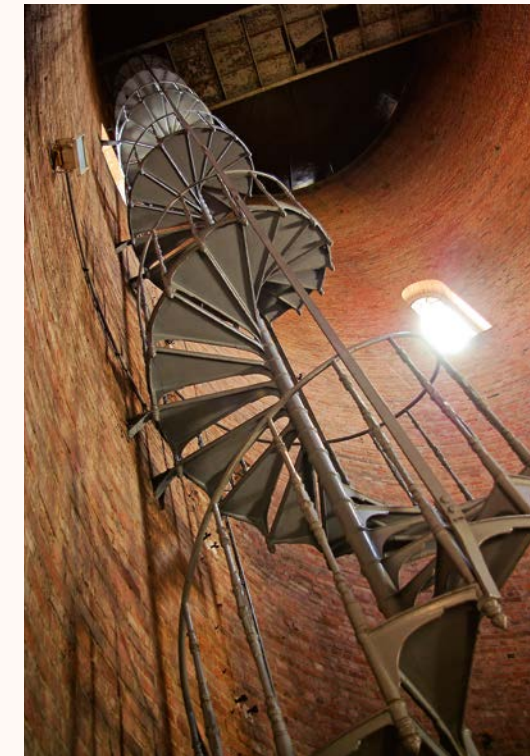
Wnętrze wieży ciśnień z widocznymi schodami kręconymi, 2007 r.
