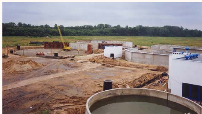
Budowa oczyszczalni ścieków w Henrykowie, lata 90. XX w. ZE ZBIORÓW MPWiK SP. Z O.O. W LESZNIE
