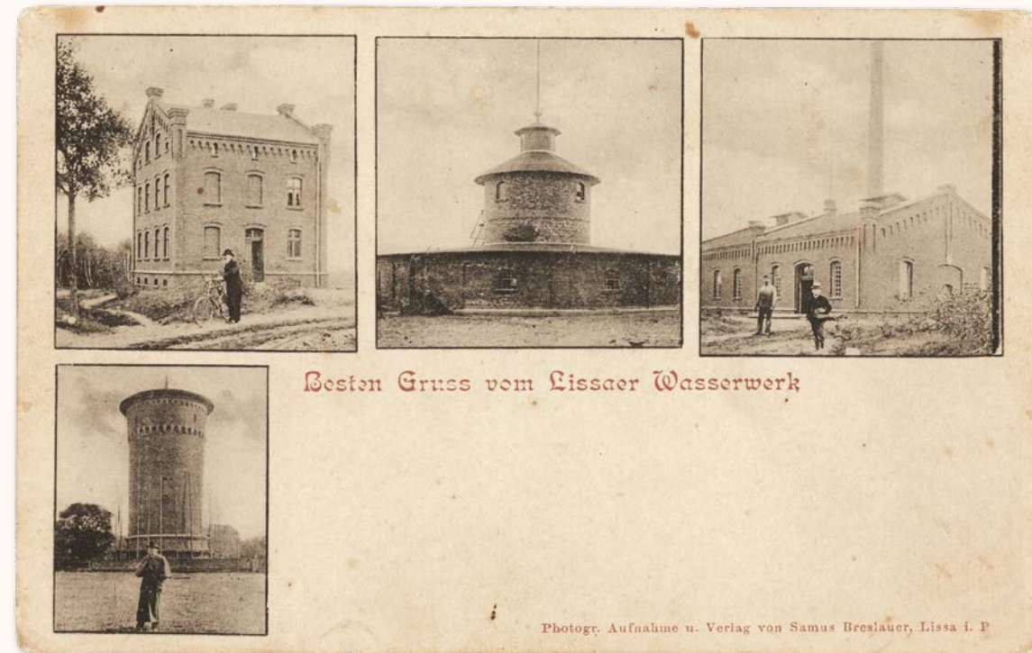
Obiekty leszczyńskich wodociągów tuż po budowie: budynek mieszkalny maszynisty i palacza, stacja filtrów, stacja pomp i kotłownia parowa oraz wieża wodna (ok. 1905 r.)
