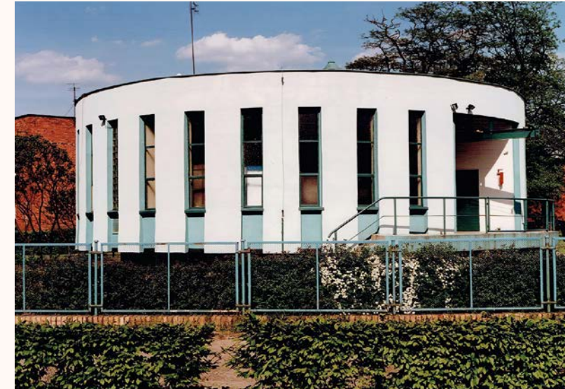
Przepompownia ścieków przy ul. Grunwaldzkiej w Lesznie, tzw. Gruba Kaśka (przed modernizacją)
