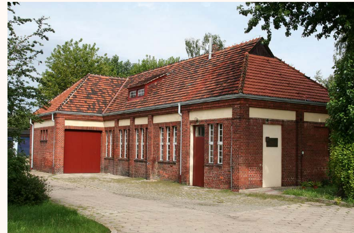
Budynek oczyszczalni ścieków ze stacją pomp w 2007 r. FOT. MIRON URBANIAK
